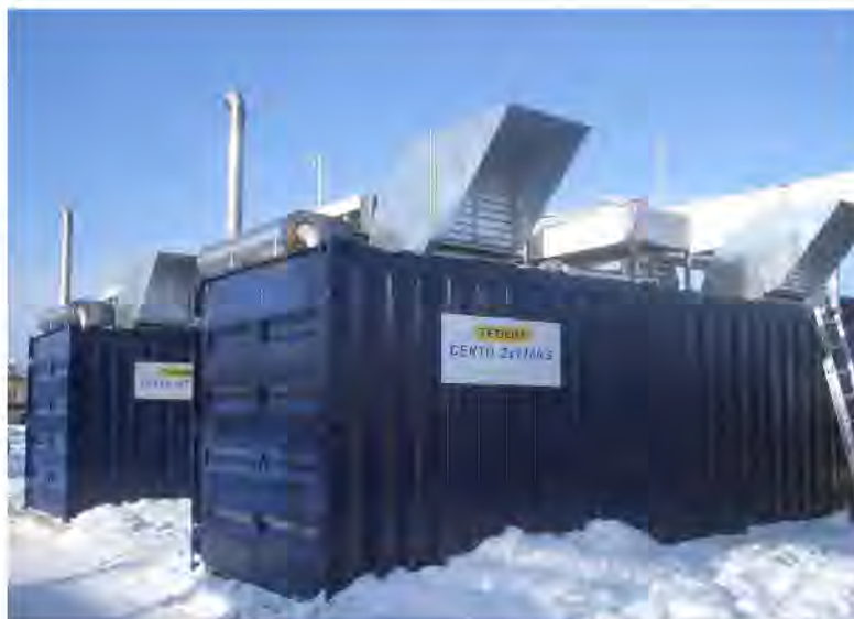
Внешний вид когенерационных установок, смонтированных в контейнерах на мясоперерабатывающем предприятии «Телец» (г. Кунгур, Пермская область).
