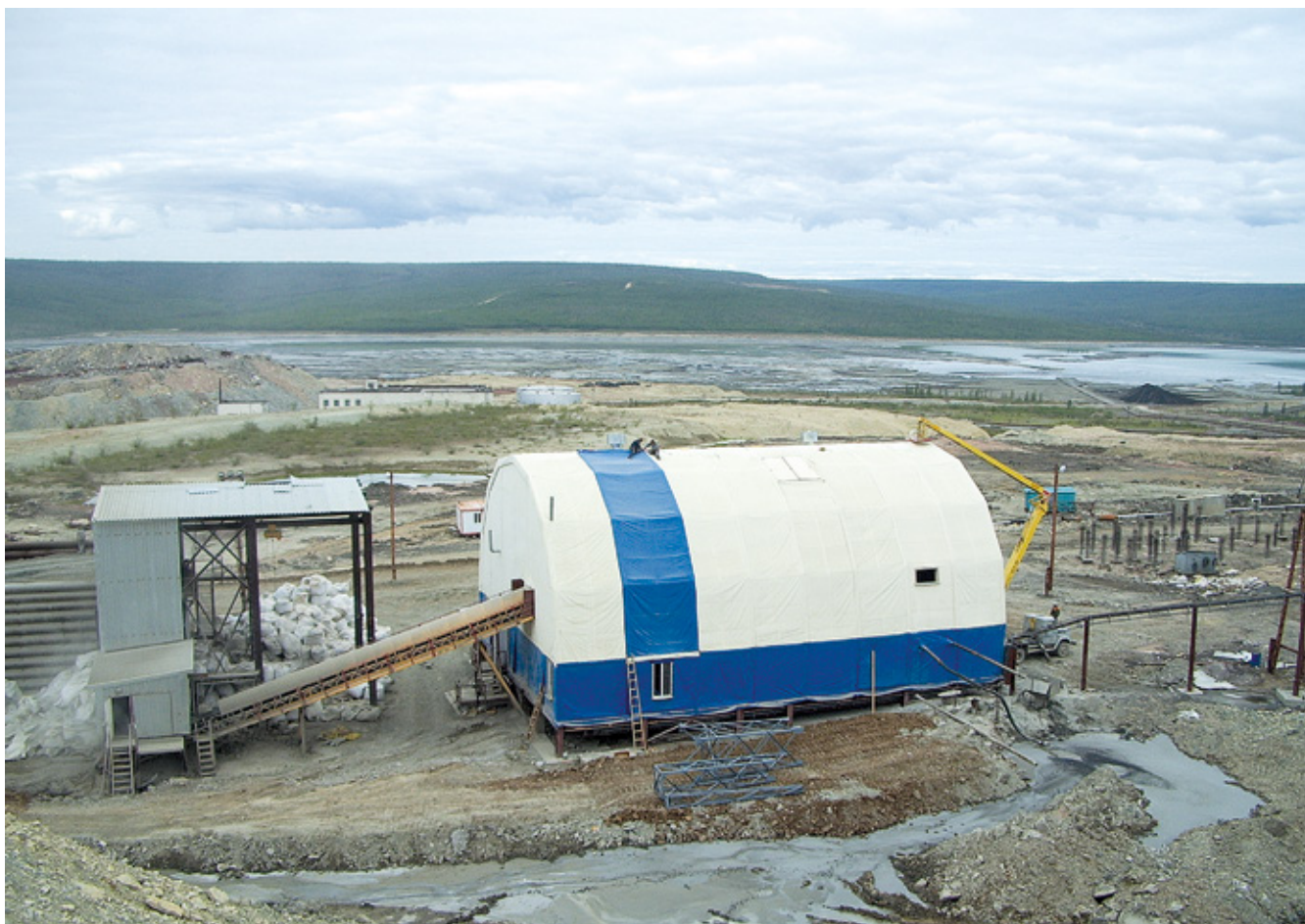
Временное сооружение мельничного отделения рудника «Айхал»
